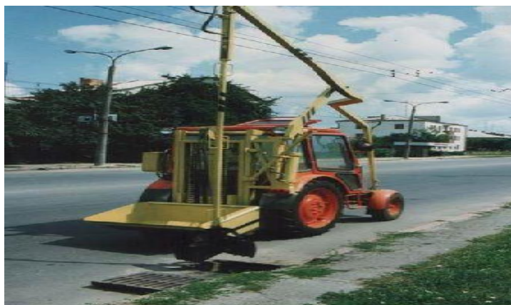
Рисунок 2 - Машина для очистки смотровых и дождевых колодцев МОК-188
