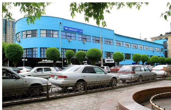
Рисунок 5 - Бывшее здание Главпочтампа нынешнее состояние
