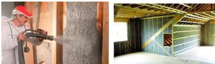
Рисунок 4 - Применение борсодержащего целлюлозного изоляционного материала [8].
